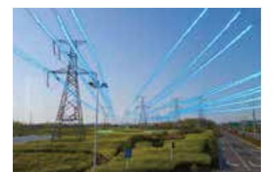
供电系统背景谐波状况电能质量评估
